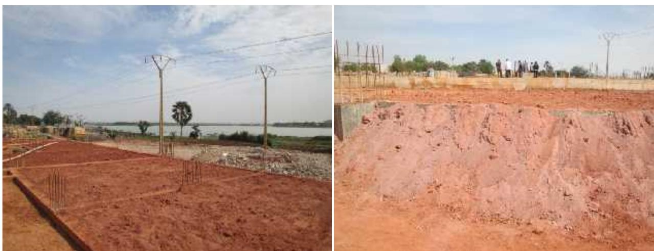
Sur cette photo, on voit que le bâtiment se trouve largement dans l'emprise de la haute tension de l'EDM et cette situation ne permet aucune élévation au risque d'exposer les ouvriers aux dangers liés à la présence.
